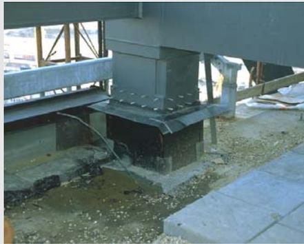
Hauptträger mit angeschweißten Stehbolzen und umlaufender Verblechung zur Aufnahme der Abdichtung
