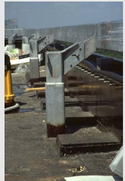
Die quadratischen Stützen halten die Schiene, an der die Fassadenreinigungsanlage aufgehängt wird.
